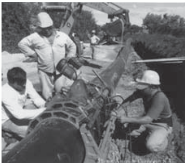
С целью непрерывного улучшения предоставляемых потребителям услуг работники Aguas de Corrientes S.A. ведут сварочные работы по замене водопроводных труб в Корриентесе (Аргентина)
